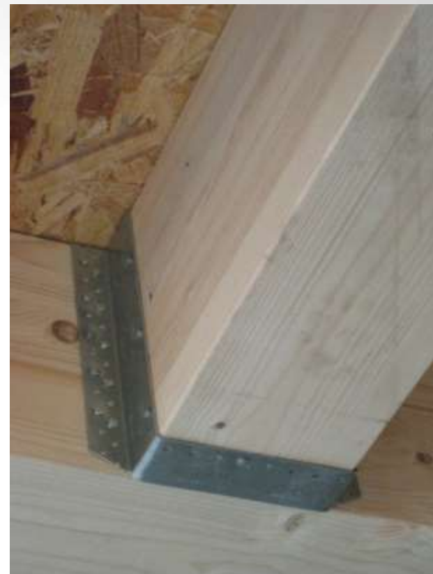
Estribo metalico con alas externas
