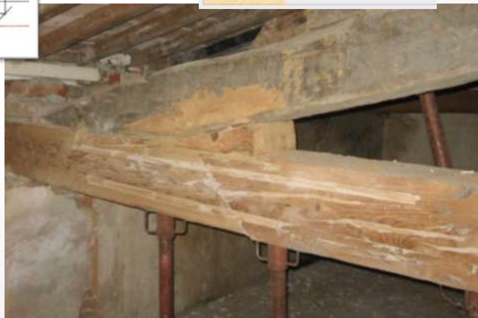
Interventi strutturali su impalcati lignei di pregio
