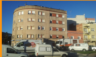
Edifici c/Condal (casc antic Barcelona):
