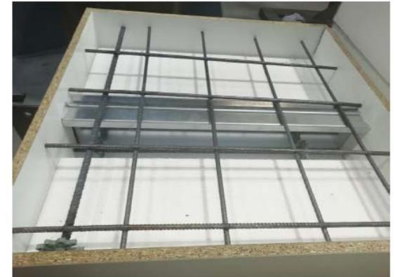
Imagen 1. Detalle muestra chapa lisa previo a hormigonado.
