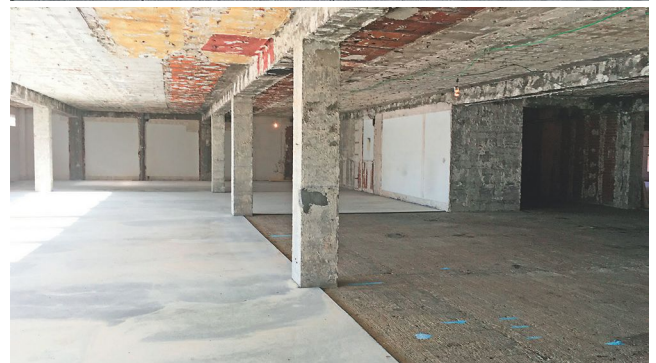
Imágenes del refuerzo estructural de los forjados del edificio de la C/ Prim, 12 en Madrid.
