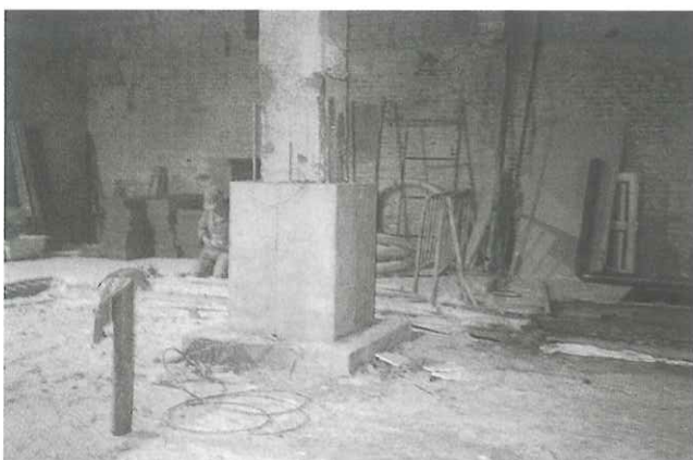
4. Zunchado de pilares a base de mortero sin retracción BETEC 140 E, previo encofrado y armado. Las esperas se reciben con BETOPOX 92 M.
