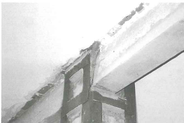
3. Zunchado metálico de pilares a base de angulares y presillas, utilizando BETEC 340 para la transmisión de esfuerzos.
