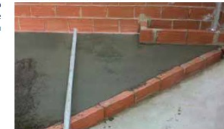
Extendido de Latermix Cem Mini.
