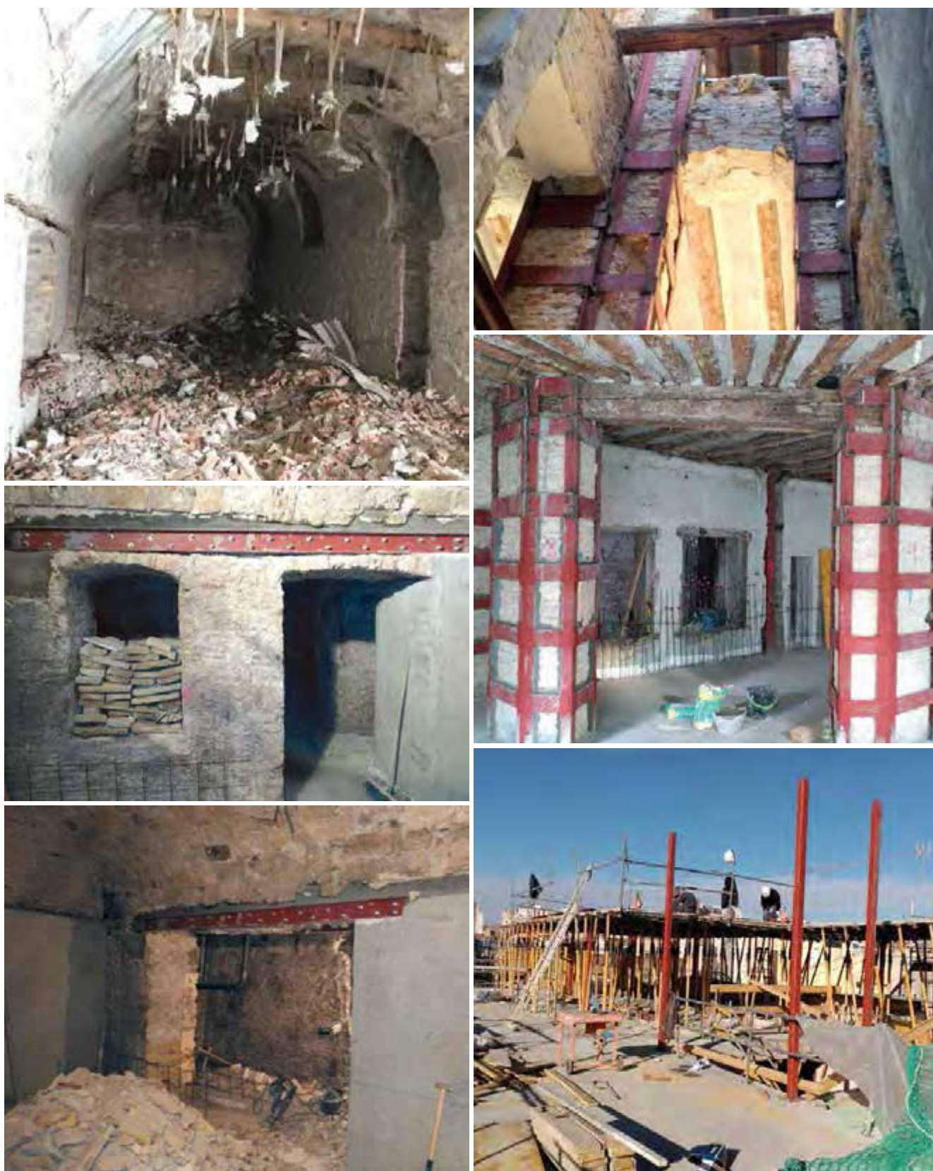
Figura 16. Diferentes intervenciones en la obra: apertura de huecos, refuerzo de machones y sustitución de la cubierta.
