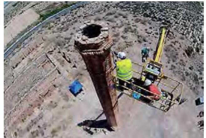
Figura 4. Instalación de acelerómetros.
