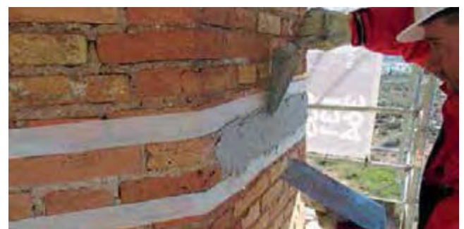
Figura 19. Primera capa de HDM Restauro.
