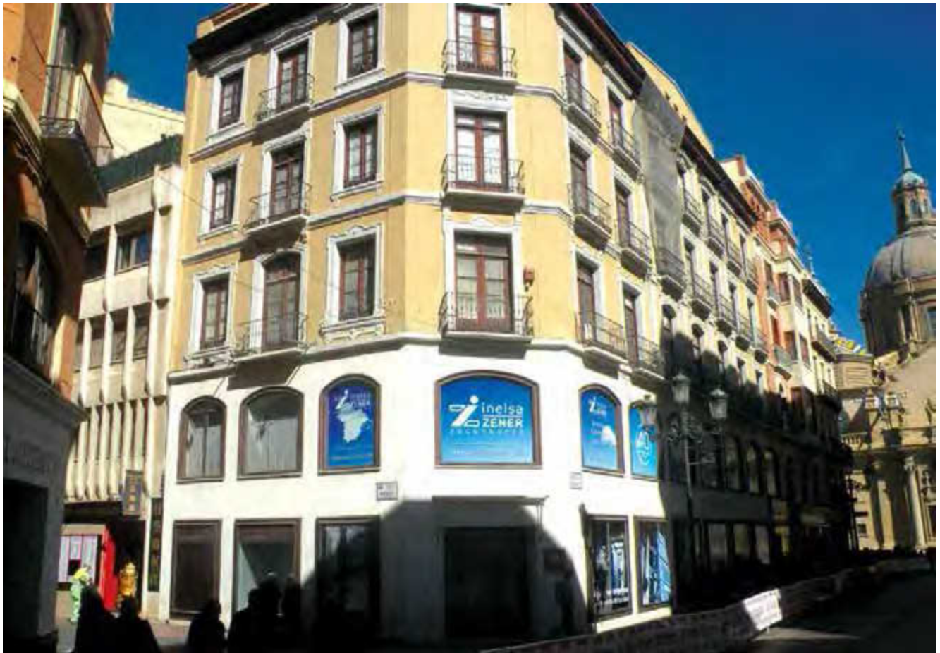
Figura 11. Fachada del edificio antes de la intervención.
