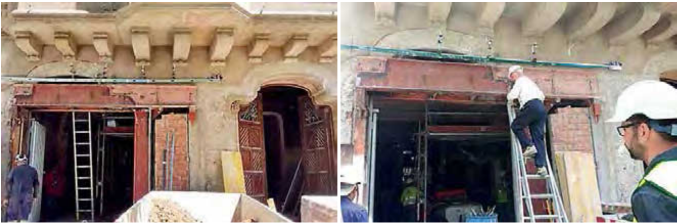
Figura 4. Restitució de la façana del Passeig de Gràcia al seu estat original desfet un estintolament fet durant els anys 70 en una reforma anterior.
