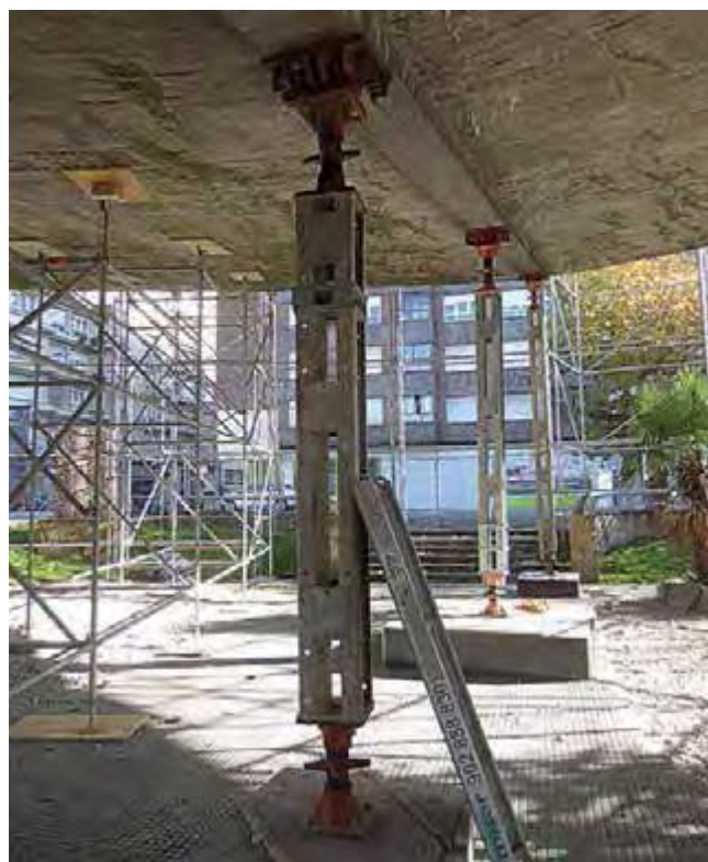
Figura 21. Puntales con las zapatas diferenciadas.
