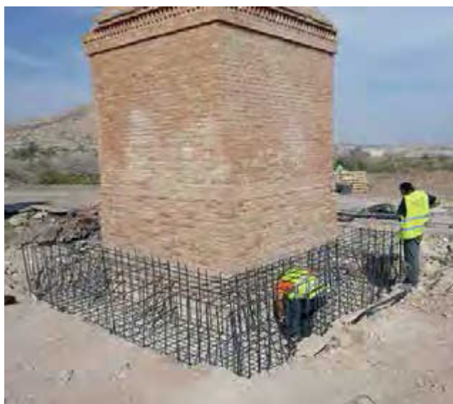
Figura 23. Vista exterior del recalce.
