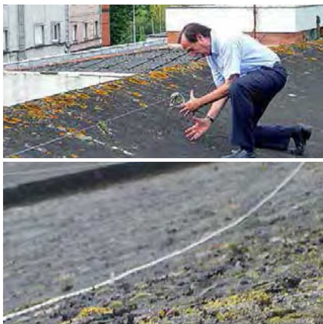
Figura 8. Fue fundamental comprobar que las láminas se adaptaban perfectamente a la catenaria.
