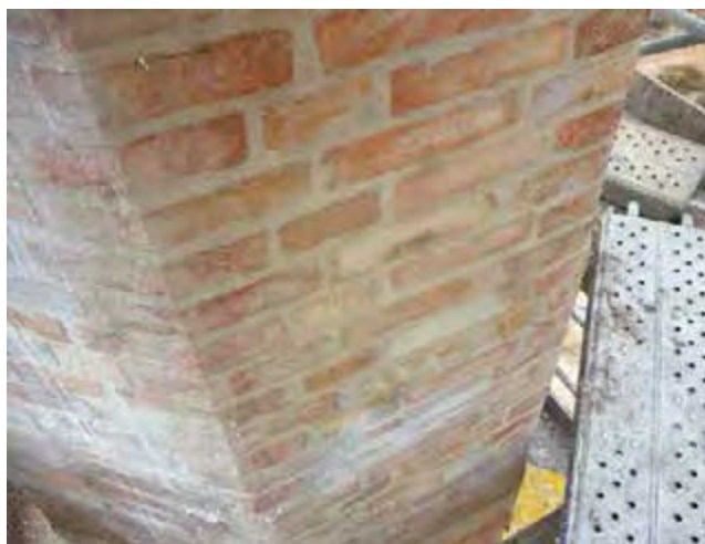
Figura 13. Rejuntado y sellado de grietas.
