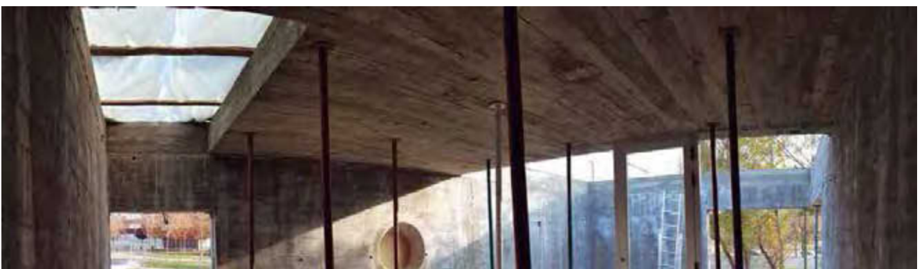
Figura 6. Vista interior de las obras.
