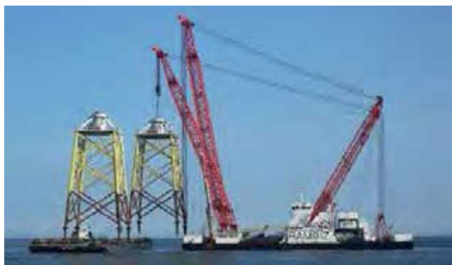
Figura 2. Grandes medios marinos necesarios para la instalación de estructuras para aerogeneradores offshore .
