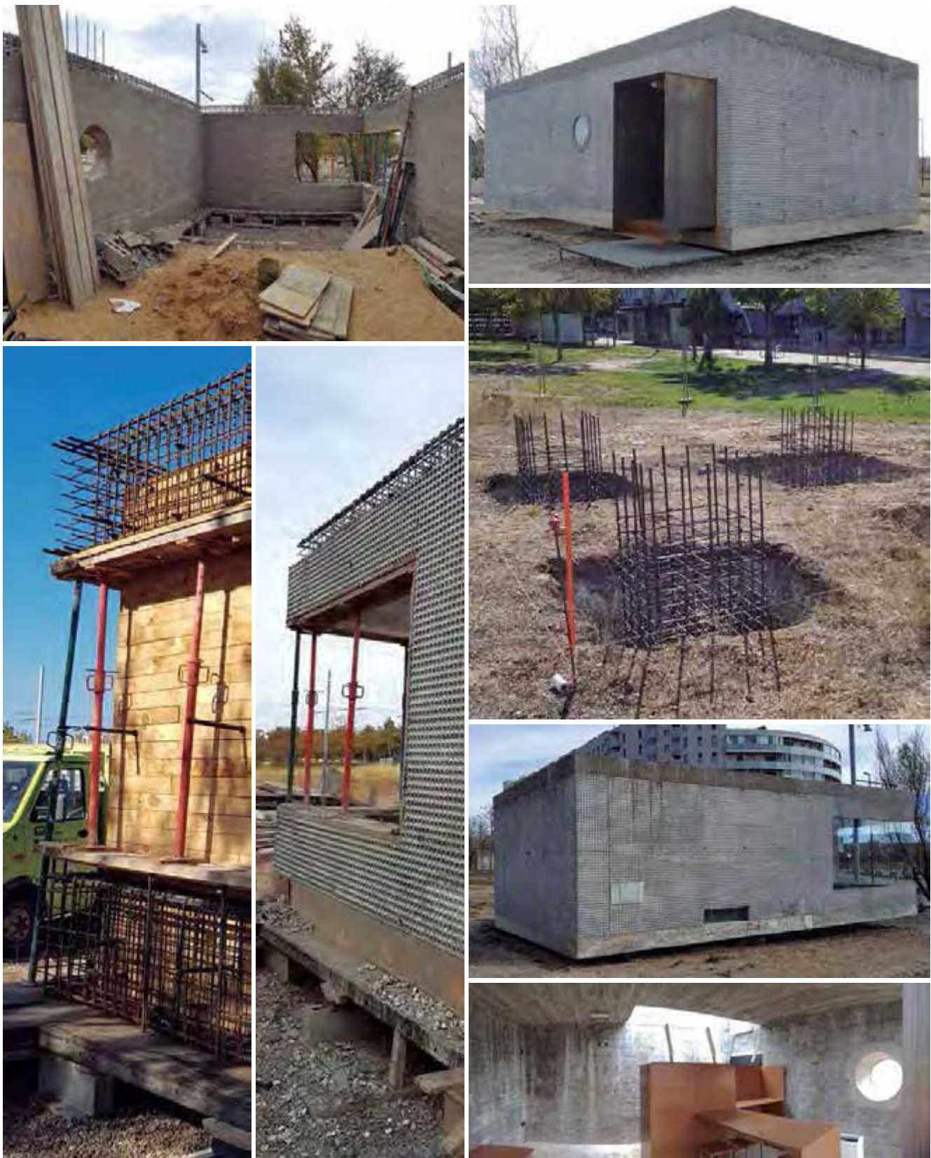
Figura 7. Vistas generales durante las obras y una vez terminadas.
