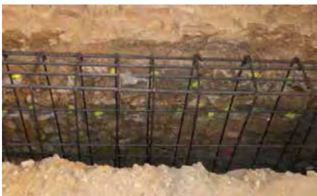
Figura 12. Detalle recrecido de la cimentación del muro central.
