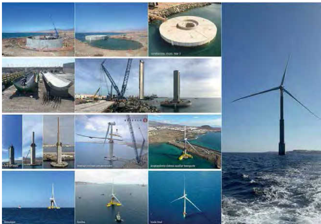
Figura 7. Diferentes fases del proceso constructivo e instalación del Prototipo en Canarias.
