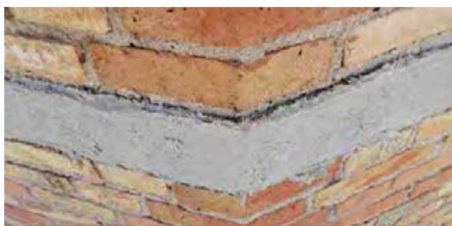
Figura 21. Aspecto final: HDM + Mapegrid.
