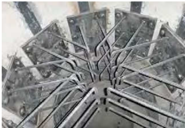
Figura 22. Anclaje FRP de cimentación.
