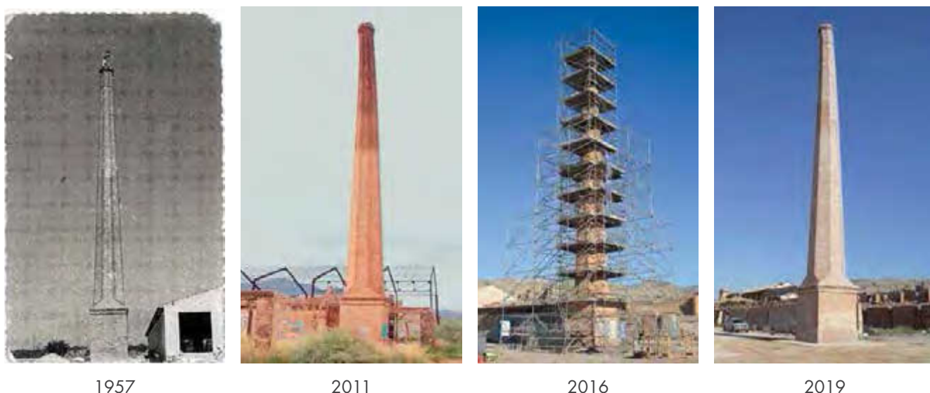
Figura 2. Evolución de la chimenea, desde su construcción hasta la fase final de la restauración.
