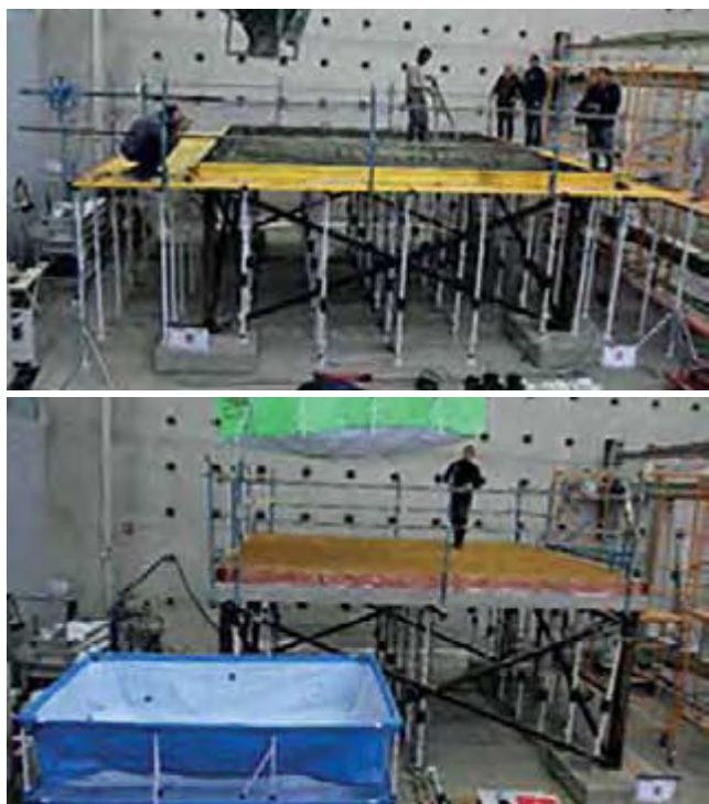
Figura 6. Hormigonado de la losa y disposición de la sobrecarga tras el clareado durante la prueba de concepto.
