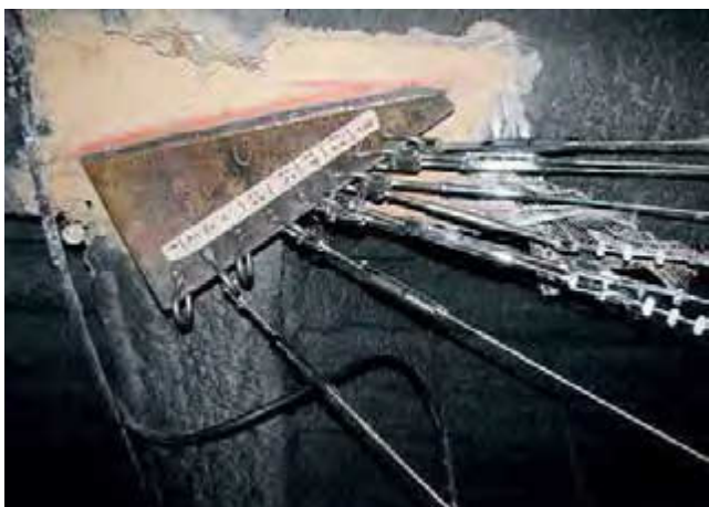
Figura 9. Una de las cuatro chapas para resolver un apoyo, soldada previa eliminación de la vermiculita.
