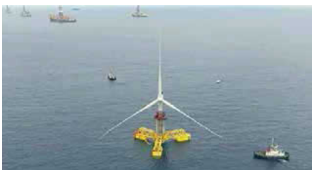
Figura 6. Torre telescópica y cimentación autoflotante.
