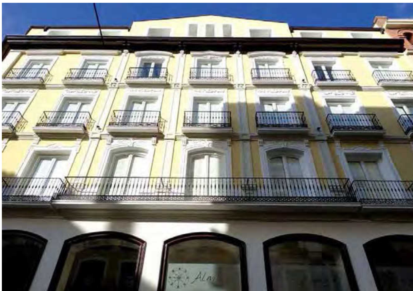
Figura 14. Fachada del edificio después de la intervención.
