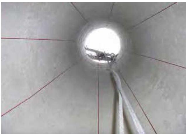
Figura 16. Replanteo de bandas FRP.
