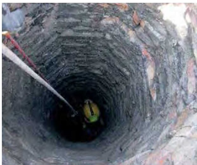
Figura 14. Limpieza y cepillado interior.
