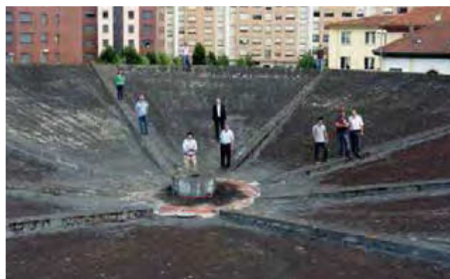
Figura 5. Imagen de la cubierta, antes de comenzar su proceso de consolidación.
