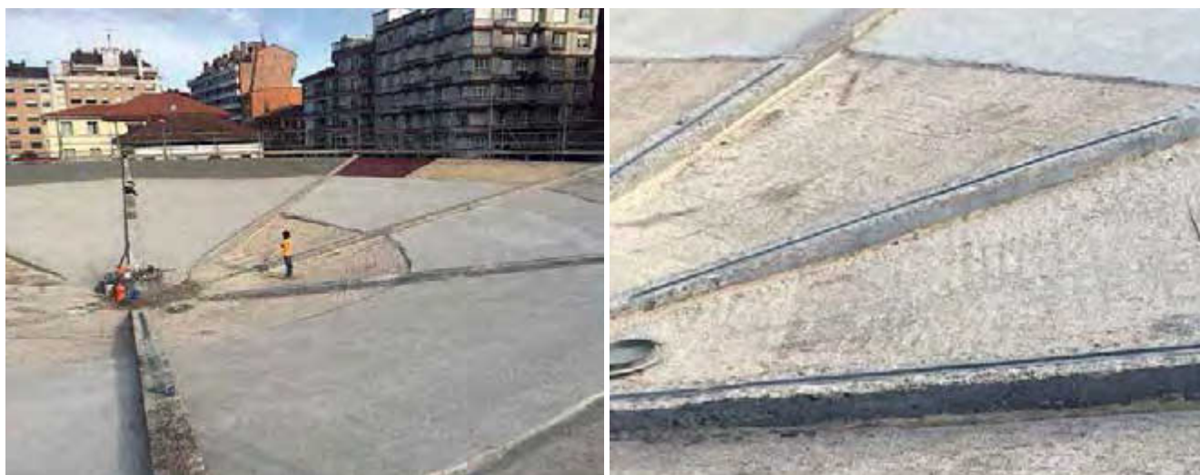
Figura 17. Introducción de láminas de carbono para cubrir el diagrama de momentos flectores.
