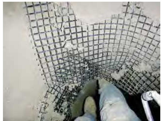
Figura 17. Colocación de Mapegrid G220.
