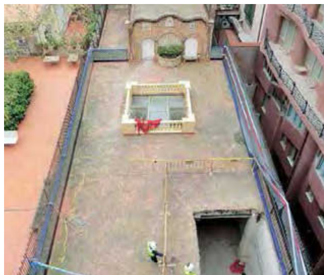
Figura 1. Enderroc i reconstrucció del pati d'illa.
