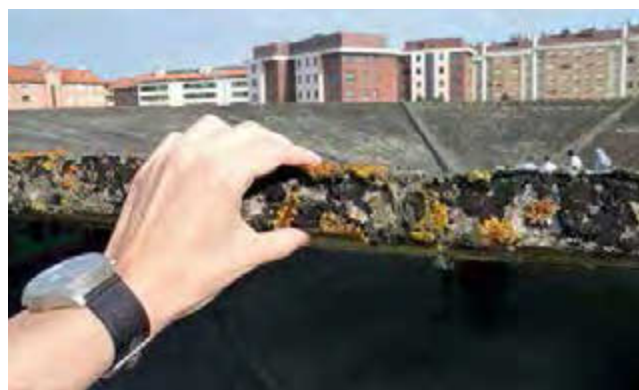
Figura 6. El espesor de las catenarias no supera los 4 cm.
