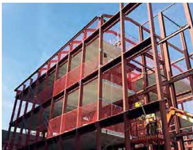
Figura 6. Foto de l'estructura metàl·lica des de l'exterior.
