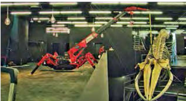
Figura 12. Proceso de montaje de la cabeza, con ayuda de una grúa fija sobre el forjado.
