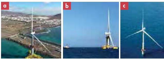
Figura 5. Tecnología ELISA. Torre telescópica y cimentación autoflotante. a) Montaje completo en puerto. b) Transporte con remolcador de puerto. c) Izado remoto de la torre telescópica con gatos hidráulicos comerciales.
