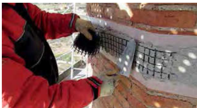
Figura 20. Colocación de Mapegrid G-220.
