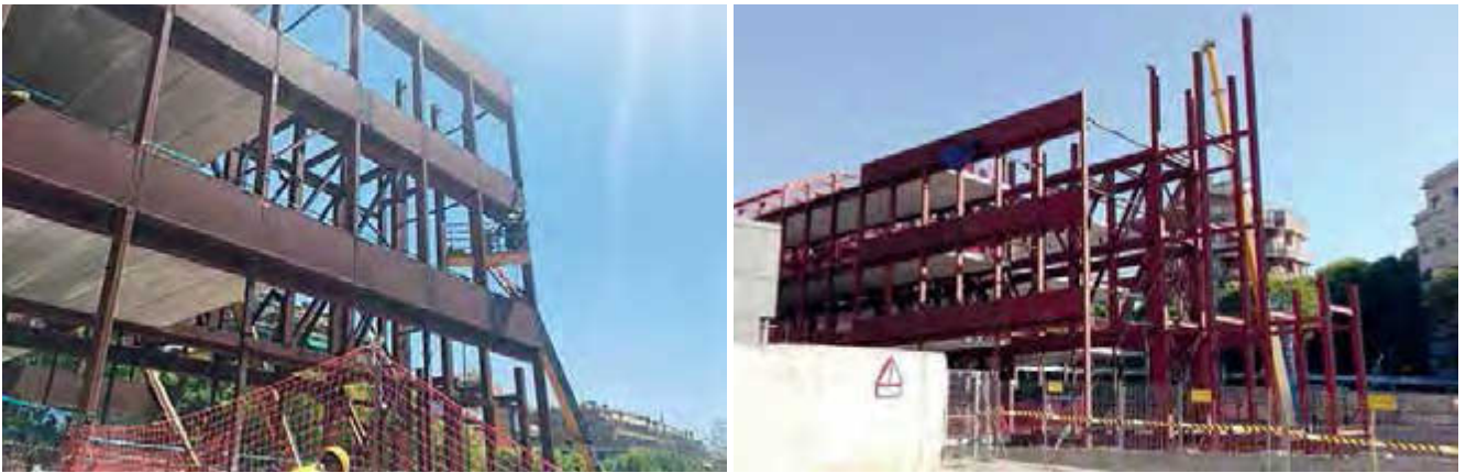
Figura 14. Muntatge de l'estructura damunt del porxo (bigues caixa de xapa).
