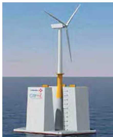
Figura 3. Soluciones autoflotantes que simplifican únicamente la instalación de la cimentación.
