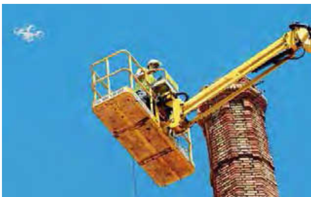
Figura 3. Validación de la inspección de lesiones realizada mediante un dron.
