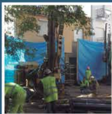
Execució de micropilots
