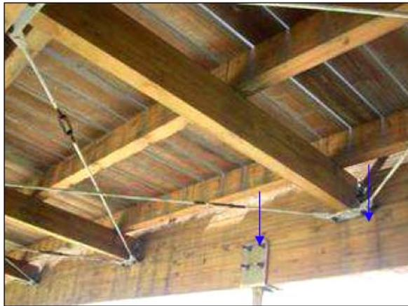
LA SOLUCIÓN PERMITE EVACUAR EL AGUA ENTRE EL PAVIMENTO Y LA PASARELA
