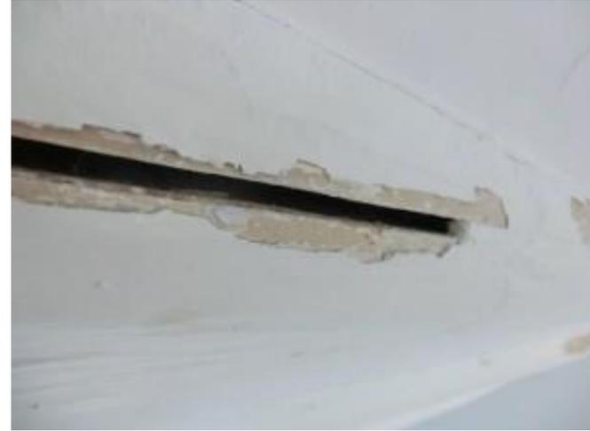
Fendas severas en sentido horizontal descubiertas bajo una capa de pintura y yeso
