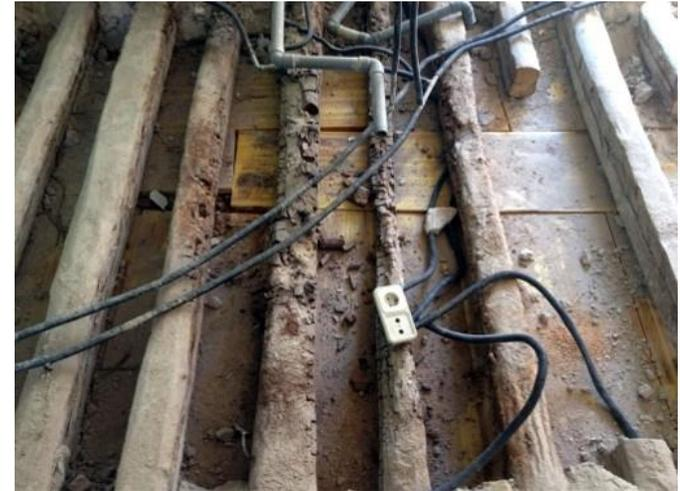
Daños estructurales graves en el forjado de madera alrededor de un bajante
