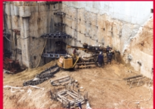
Ancoratges sota el nivell freàtic per a l'estabilització de mur pantalla al Gran Teatre del Liceu a Barcelona
