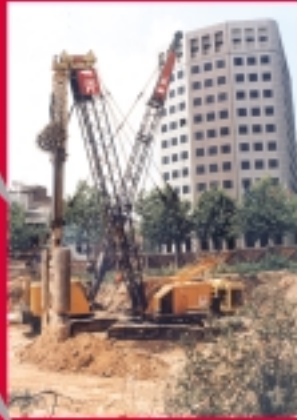
Mur pantalla a l'Edifici Winterthur (L'Illa Diagonal)
