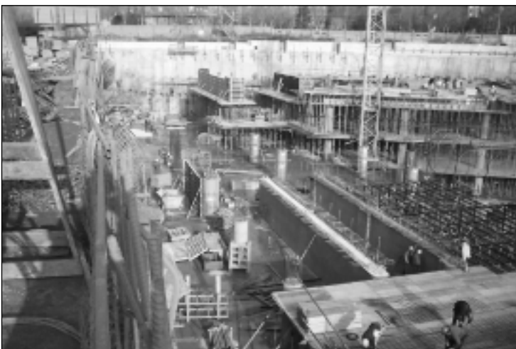
Fig. 10. Vista de una zona donde se aprecia la gran complejidad de la estructura.
