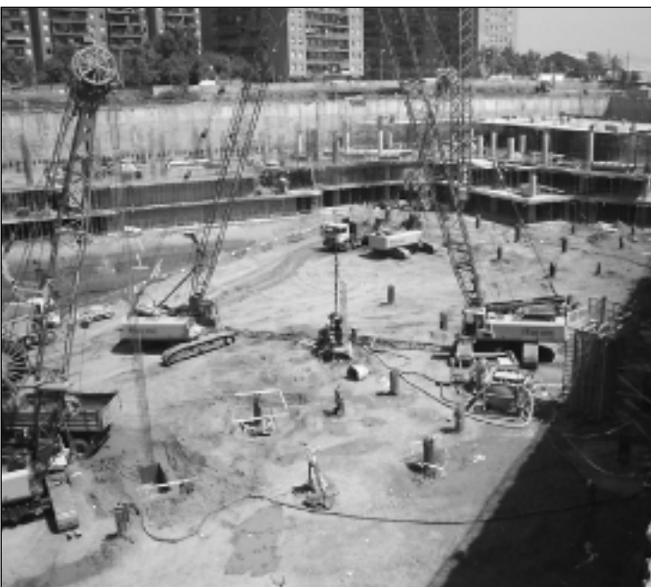
Fig. 8. Ejecución de pilotaje prefabricado en Zona central.
