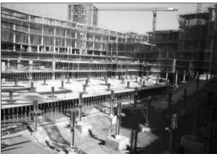
Fig. 12. Vista general con relleno de tierras, pilares de acero, encofrado y plantas acabadas.
