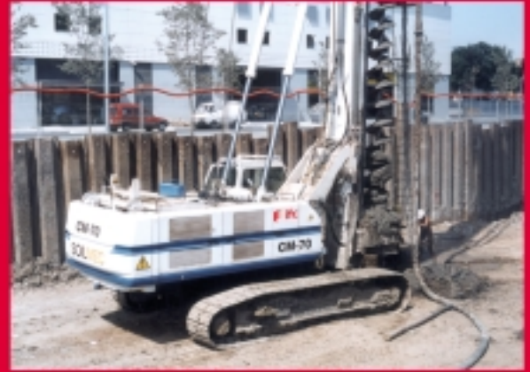
Pilots amb barrina contínua de longitud superior a 30 metres al Centre Comercial "La Maquinista" a Barcelona
