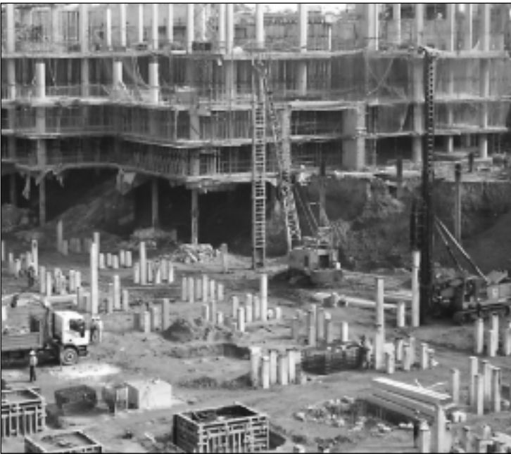
Fig. 7. Vista general. Pueden verse los solapes de los pilares metálicos enterrados.
